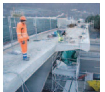
Des éléments du pont doivent être découpés et enlevés. DR
