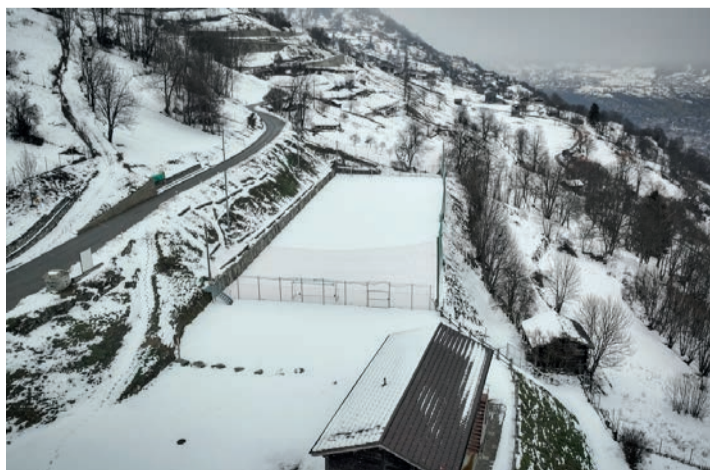
Die Sanierung des Munder Sportplatzes wird frühestens im Herbst beendet sein.
